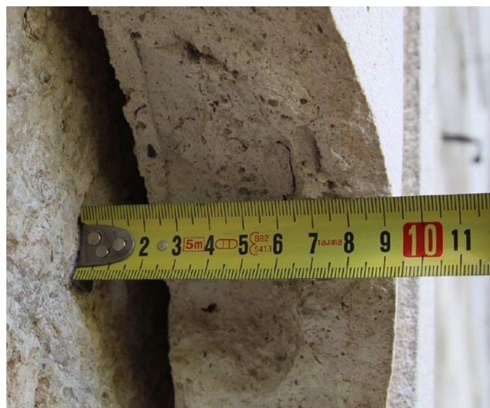
En haut (gauche) : façade ouest. En haut (droite) : les enduits de plâtre recouvrent les tours du XVI e siècle et forment le décor de la corniche et des baies. En bas (gauche) : détail de la corniche faite de pierres de taille et de briques armées par du métal puis enduite en plâtre. En bas (droite) : l'épaisseur de l'enduit va de 3 à 7cm, décollé par endroit quand les pierres sont trop lisses. (Photographies Tiffanie Le Dantec, 2017).
