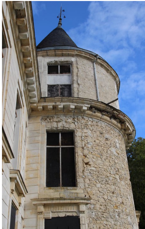
En haut (gauche) : façade ouest. En haut (droite) : les enduits de plâtre recouvrent les tours du XVI e siècle et forment le décor de la corniche et des baies. En bas (gauche) : détail de la corniche faite de pierres de taille et de briques armées par du métal puis enduite en plâtre. En bas (droite) : l'épaisseur de l'enduit va de 3 à 7cm, décollé par endroit quand les pierres sont trop lisses. (Photographies Tiffanie Le Dantec, 2017).
