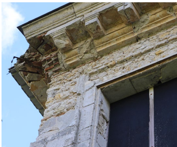
En haut (gauche) : façade ouest. En haut (droite) : les enduits de plâtre recouvrent les tours du XVI e siècle et forment le décor de la corniche et des baies. En bas (gauche) : détail de la corniche faite de pierres de taille et de briques armées par du métal puis enduite en plâtre. En bas (droite) : l'épaisseur de l'enduit va de 3 à 7cm, décollé par endroit quand les pierres sont trop lisses. (Photographies Tiffanie Le Dantec, 2017).
