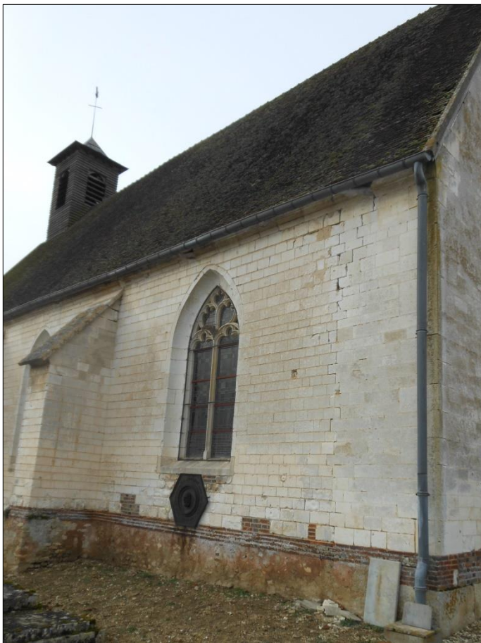
Chapelle Saint-Avit, côté Sud, et monument de Pierre Mocquot, 2014.
