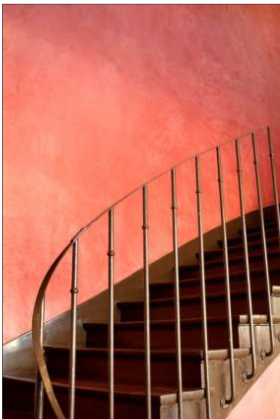
Stuc au plâtre, stuc intérieur rouge Pompéi, Vaugneray (Rhône).
