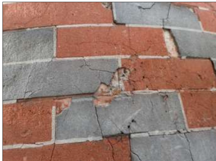
Exemple de stuc brique bichrome avec motif en zig-zag sur un pigeonnier à L'Isle-Adam (Val-d'Oise.) Photo Rémi Langlais.
