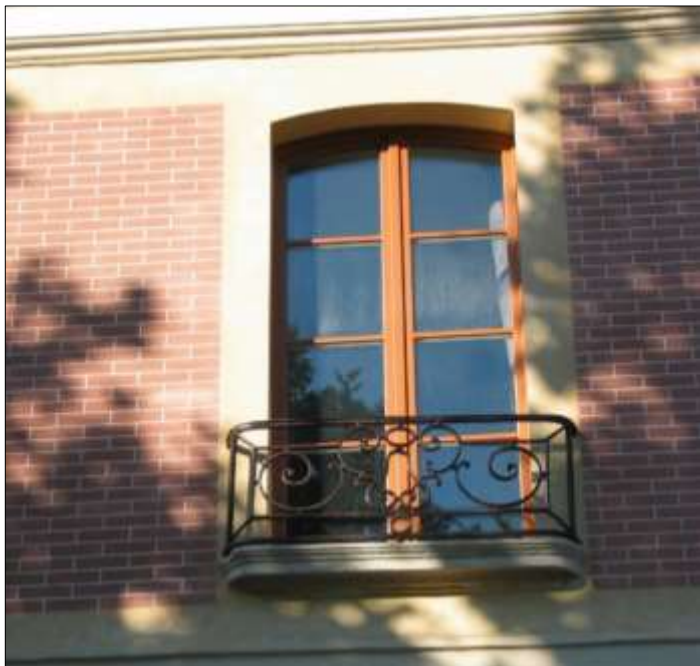
Façade en pan de bois à Versailles. Enduit de plâtre coloré type stuc brique et appareils de pierre simulé en plâtre ocrés.
