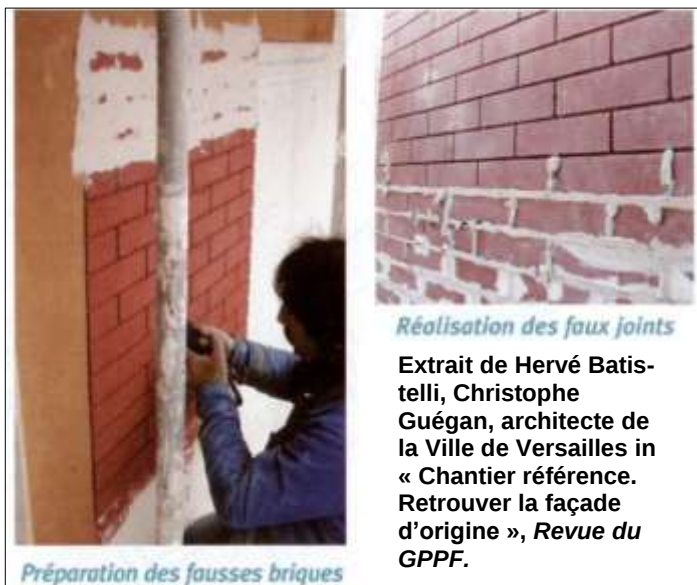
Façade en pan de bois à Versailles. Enduit de plâtre coloré type stuc brique et appareils de pierre simulé en plâtre ocrés.
