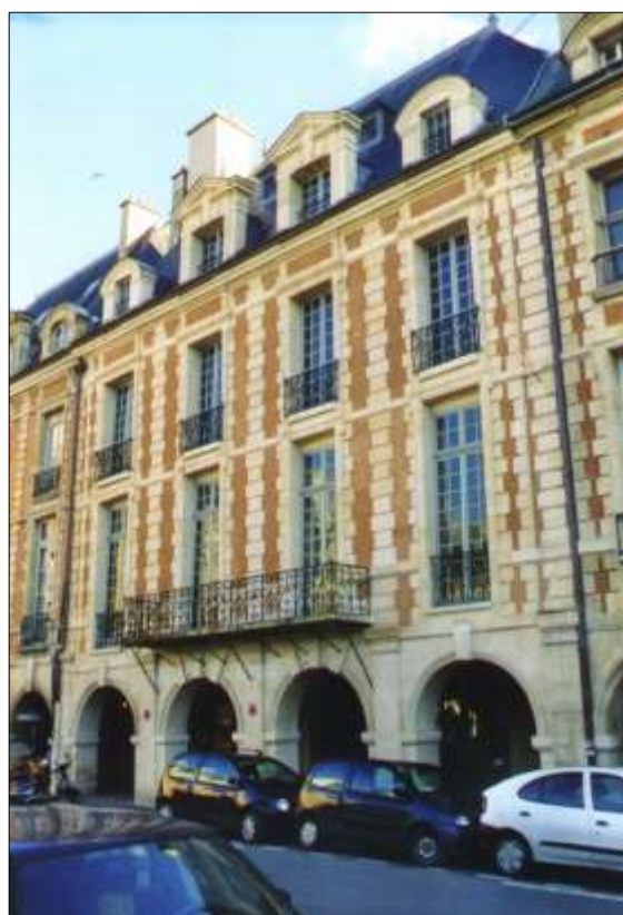
Immeuble place des Vosges à Paris.
