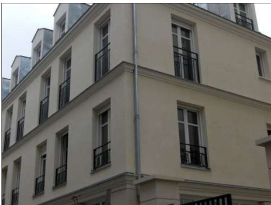
Façade parisienne à plâtre teinté dans la masse.
