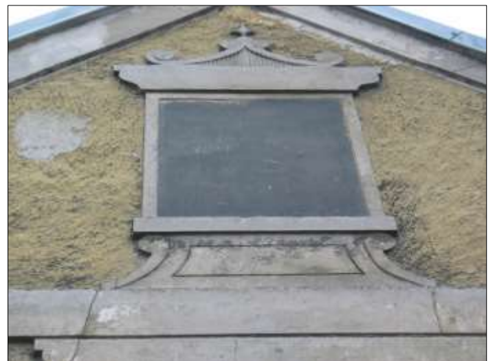
Maison de ville à Montfermeil (Seine-St-Denis) enduite au plâtre, façon de pierre simulée, mouchetis ocre, fenêtres factices.
