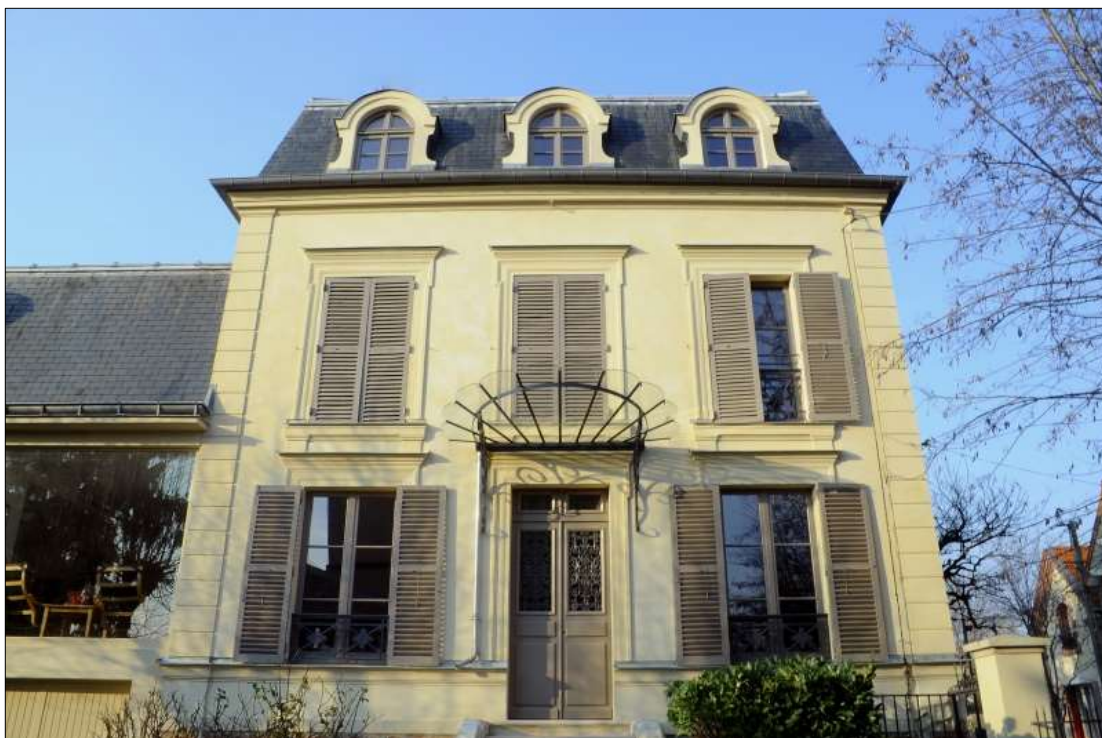
Restauration d'une maison au Raincy (Seine-St-Denis), enduits et modénatures en stuc pierre.
