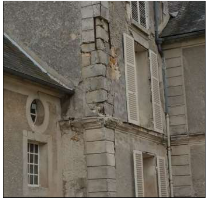
Façades du château de Janvry (Essonne) en enduit de plâtre, modénatures en appareil de pierre simulé et tapisseries en jetis de plâtre teinté dans la masse de couleur gris.
