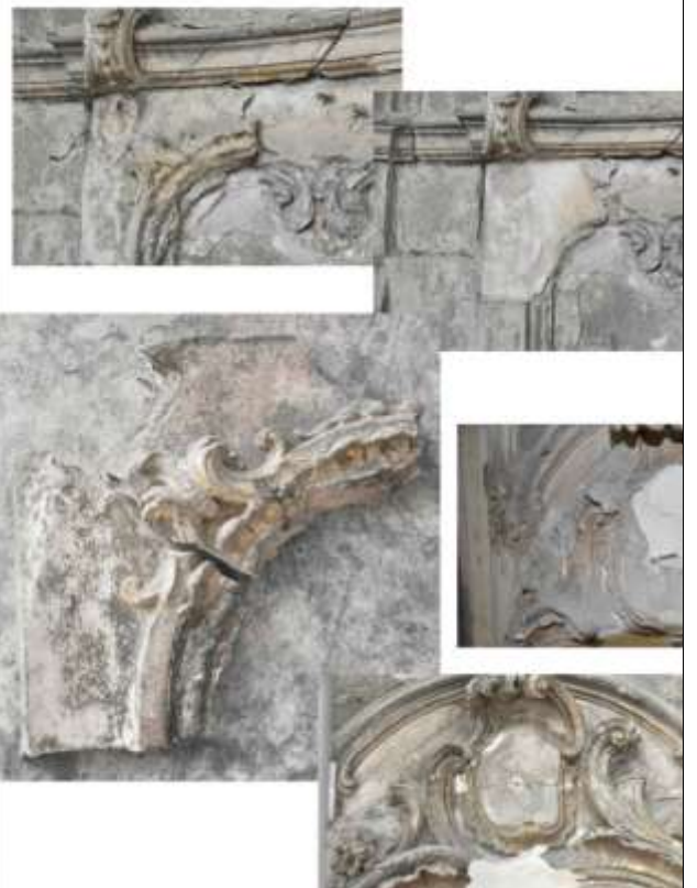
Dépose de fragments divers et recollage à la résine époxyde le long des corniches
