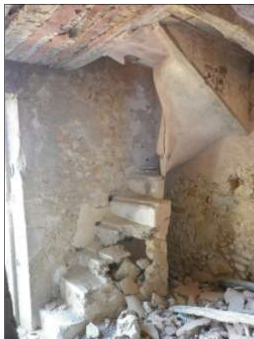
Fig. 10 : Cazouls (Hérault). Escalier, enduit de finition et sol d'étage en plâtre rose dans une maison de vigneron située au milieu des vignes sur le terroir de Cazouls. Les carrières sont situées à 300 mètres de cette maison rurale et isolée.
