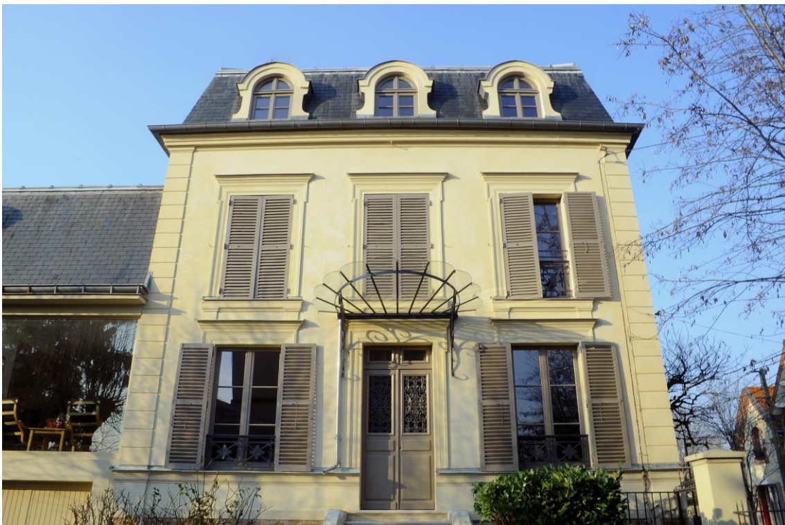
Fig.4 - Maison restaurée en région parisienne à la façade enduite et aux modénatures en stuc pierre. Photo Frédéric Charpentier
