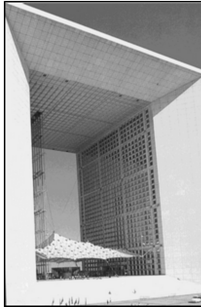
La Grande Arche de la Défense, 1989. Un cube de béton de 100 x 100 mètres revêtu de 2450 plaques de marbre de Carrare montées sur vérin. Extrait de l'ouvrage.
