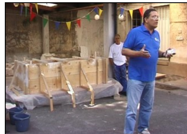
Claude Collot, ingénieur chef de projet chez BPB Formula (anc' Plâtres Lambert). Le grand coffrage en bois est prêt à recevoir 800 Kg de plâtre. Photo Laurent Person, extraite du film.
