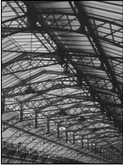
La verrière de la gare de l'Est, 1847-1852. Extrait de l'ouvrage.
