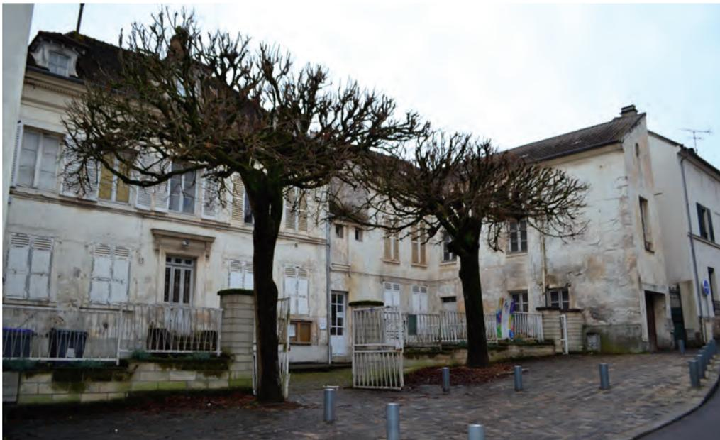
*Vue de la façade côté rue : la hauteur du sol à la corniche est de 7,88 m. Ici, l'enduit, blanc et pur, est fait de plâtre industriel. Néanmoins, quelques sondages réalisés dans le passé permettent d'entrevoir les couches antérieures. À droite se trouve la seconde maison.*
