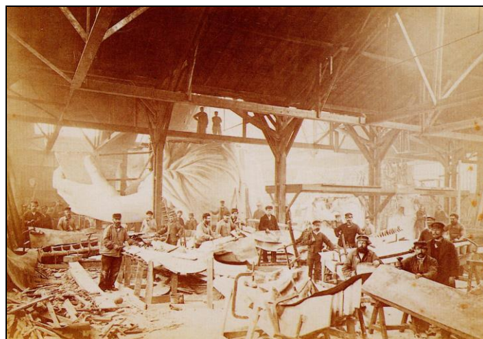
Etape de la construction vers 1883. Préparation en plâtre du bras gauche. Collection Musée National des Arts-et-Métiers.
