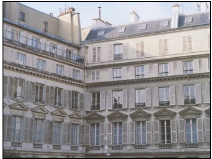
Immeubles de logement, place du Palais-Bourbon (Paris 7 e ), construits en 1787 et enduits de plâtre. Corniches, modillons et frontons sont également en plâtre.
