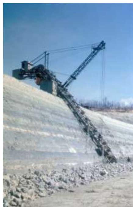
► 8 - Excavateur à godets en service à la carrière de Cormeilles, 1967.
