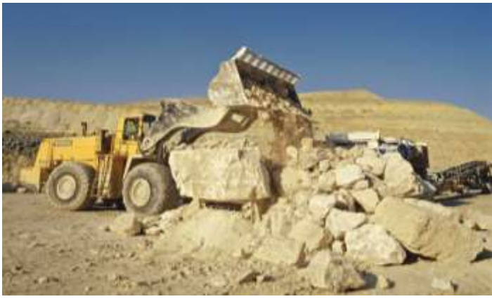
► 25 - Chargeuse sur pneus alimentant le concasseur en carrière, années 1980.
