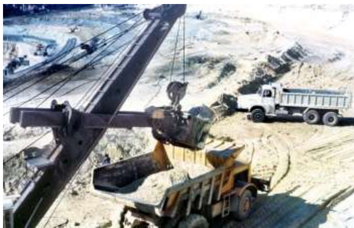
► 16 - Pelle à câbles chargeant du stérile dans un tombereau Kaelble, 1967.
