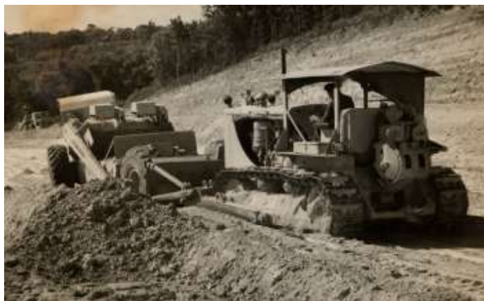
► 20 - Bouteur Caterpillar poussant un scraper Le Tourneau. Cette fois, les conducteurs disposent de canopies les protégeant du soleil mais pas du froid, des poussières ou du retournement de l'engin, années 1960.
