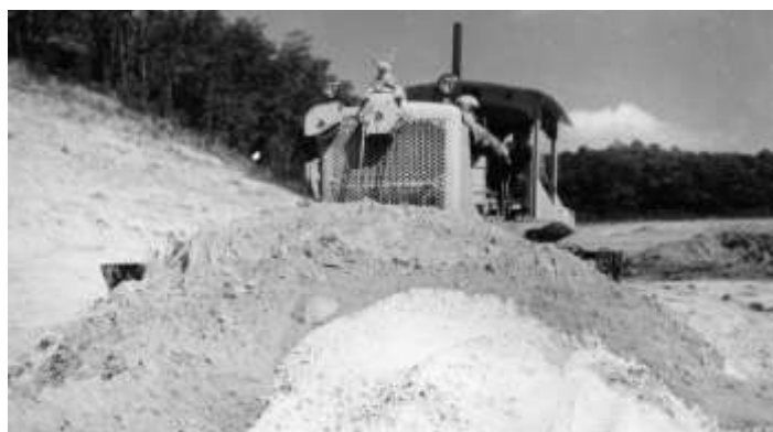
► 19 - Bouteur poussant un scraper au début de l'arrivée de ces engins. Les postes de conduite ne sont pas protégés par des cabines, années 1950.
