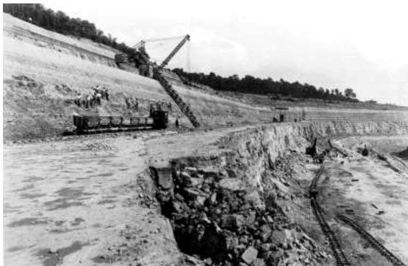
► 12 - Équipe de terrassiers arrachant au pic les terrains trop durs pour pouvoir être extraits par l'excavateur à godets, années 1940-50.
