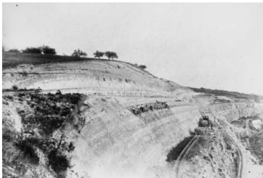
► 6 - Ouvriers travaillant à l'arrachement des marnes de recouvrement (années 1900). Au pied de ce front, stationnent des berlines tractées par la première locomotive à vapeur entrée chez Lambert, une Decauville 021T de 1897.
