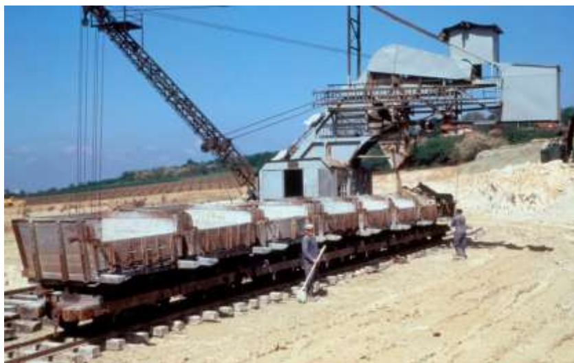
► 10 - Berlines en cours de chargement par l'excavateur à godets, 1963.
