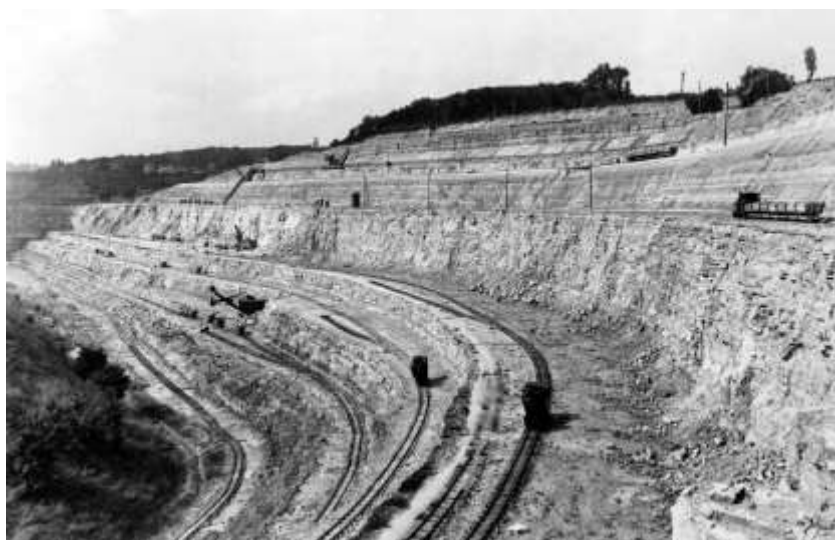
► 11 - Vue d'ensemble de la carrière (années 1940-50), avec deux excavateurs à godets que Lambert a utilisé simultanément sur le même gradin. Le premier, au fond à gauche, remonte vers l'amont les marnes arrachées, tandis qu'à droite, le second, fait descendre vers l'aval la terre arrachée.
