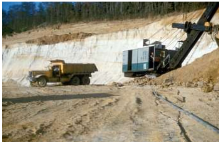
► 17 - Pelle à câbles sur chenilles chargeant du gypse dans un tombereau de carrière, années 1960.
