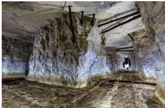
► 2 - Vue de cavages de gypse dans l'ancienne carrière souterraine d'Annet-sur-Marne (Seine-et-Marne).
