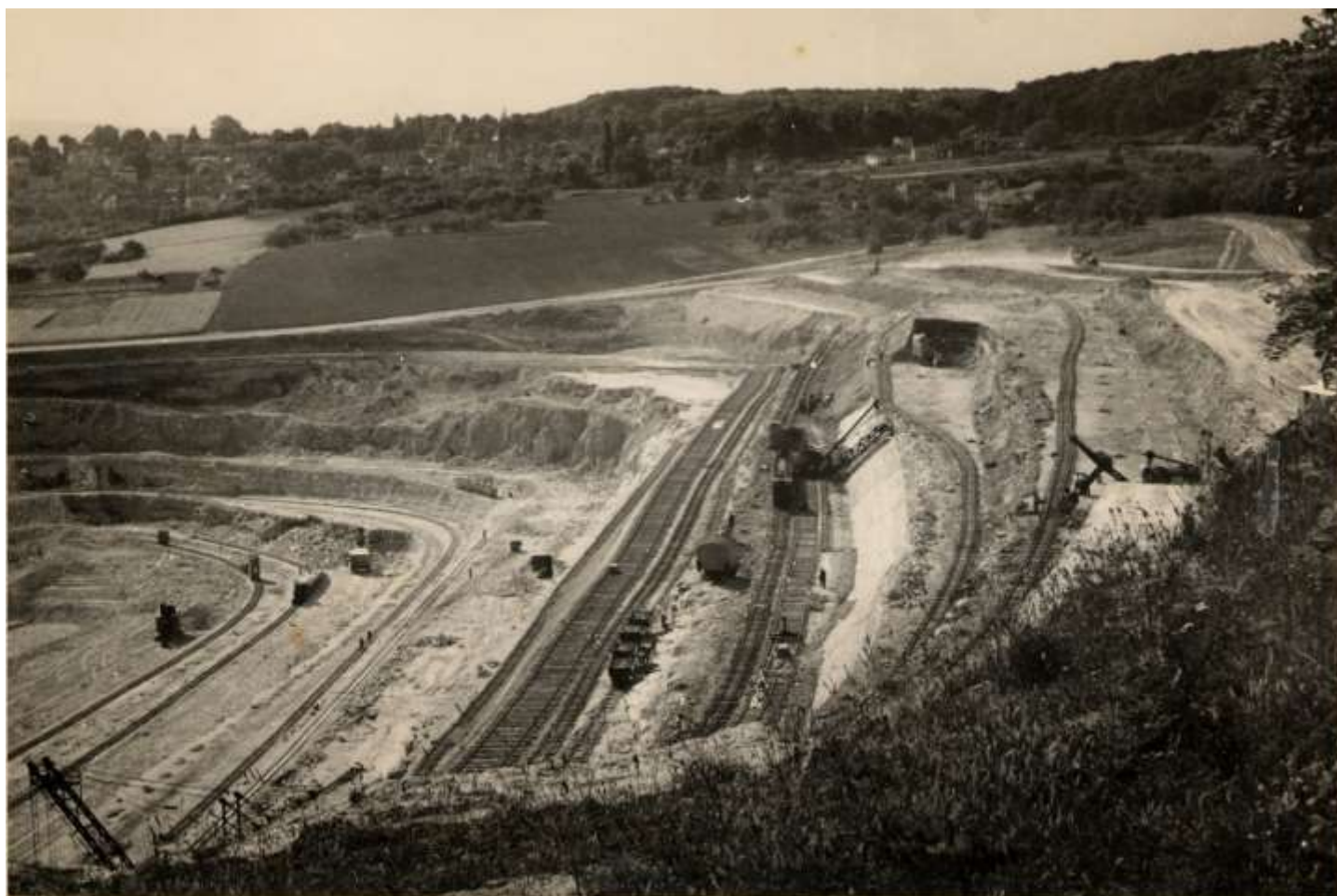
► 1 - Vue d'ensemble de la carrière de Cormeilles montrant l'activité des différentes machines et la forte densité des voies ferrées, années 1950.
