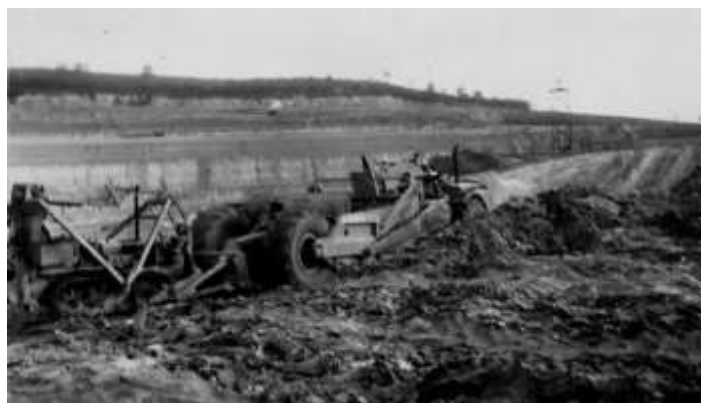
► 19 - Bouteur poussant un scraper au début de l'arrivée de ces engins. Les postes de conduite ne sont pas protégés par des cabines, années 1950.
