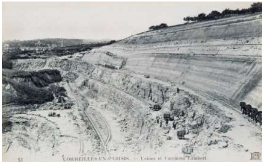
► 5 - Vue de la carrière de Cormeilles avant la mécanisation de la découverte (années 1900). À gauche on peut observer un attelage de quatre chevaux ou mulets.
